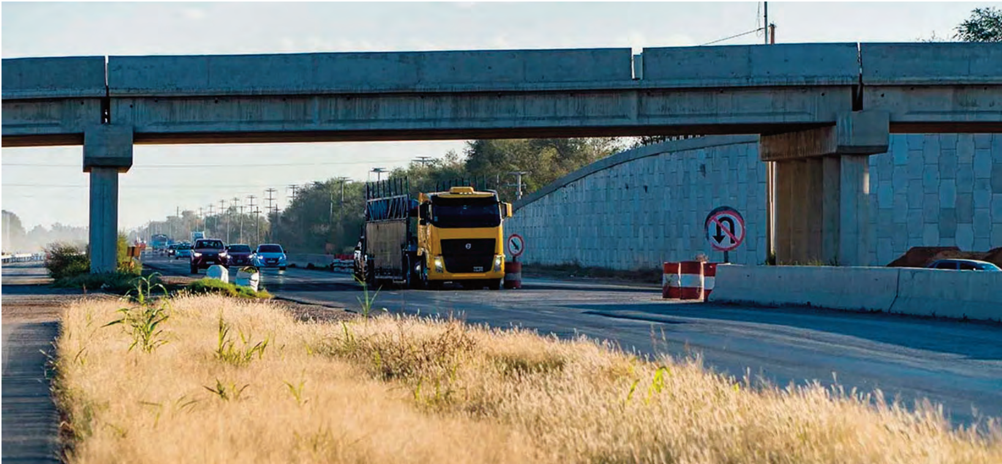
Hoy sólo 8 obras viales están en marcha, entre ellas la de la autovía a Holmberg.
