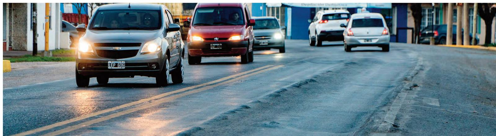
**También es muy común ver el ahuellamiento en rutas, que es un tipo de deterioro en los pavimentos asfálticos que se caracteriza por la deformación causada por la repetición de cargas del tráfico.**
