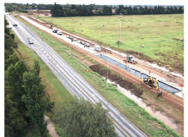
la creación de una intersección para retorno. Se prevé un perfil tipo boulevard de dos calzadas con dos carriles de circulación por sentido, divididas con un cantero central donde se ubicarán las luminarias.
