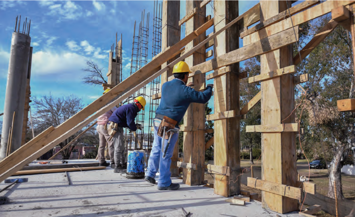
El sector de la construcción sigue sin reaccionar y es un generador de empleo que por ahora no suma.
