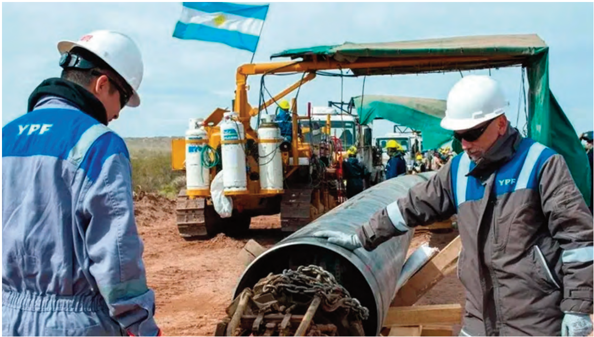
La construcción dio los primeros pasos en enero: ahora avanzan con la movilización de contratistas.
