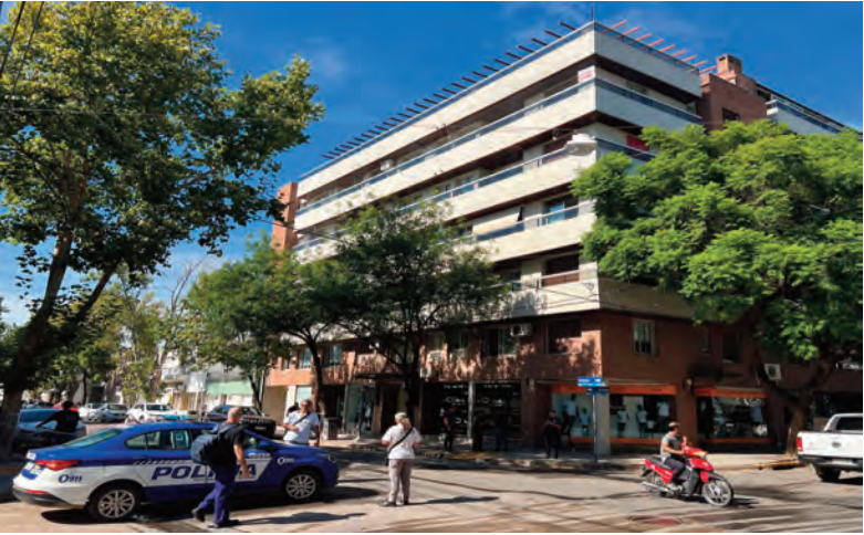
El fuego se originó por unos cables situados en un ascensor.
