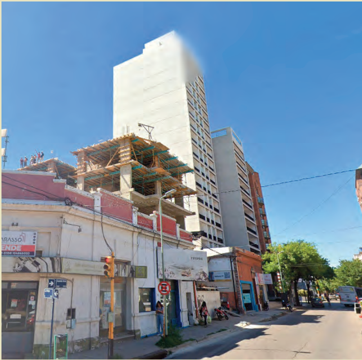
El fatal episodio tuvo lugar en un edificio en construcción.
