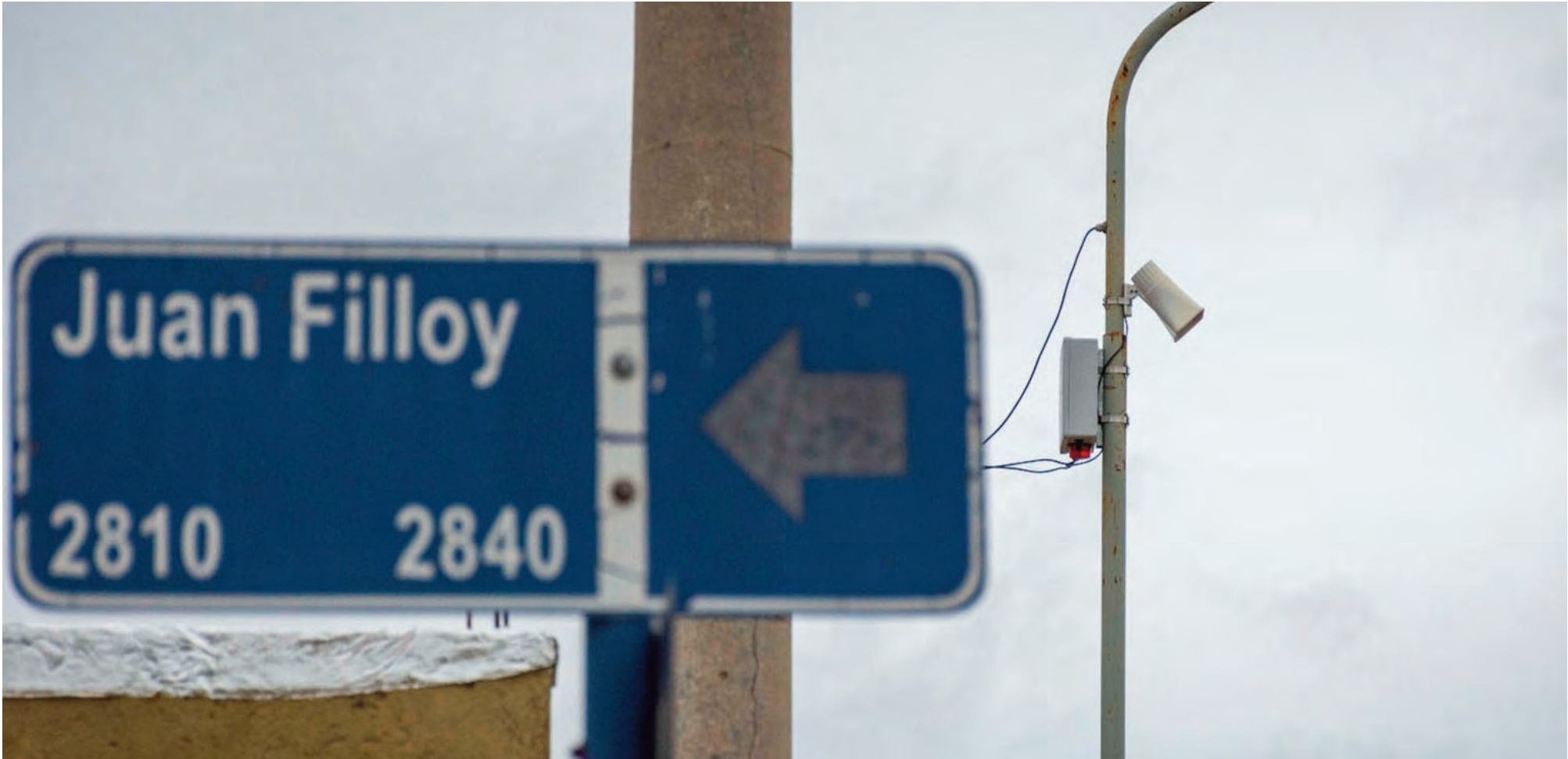
El sistema de alarmas comunitarias, instalado en sectores estratégicos de cada barrio.
