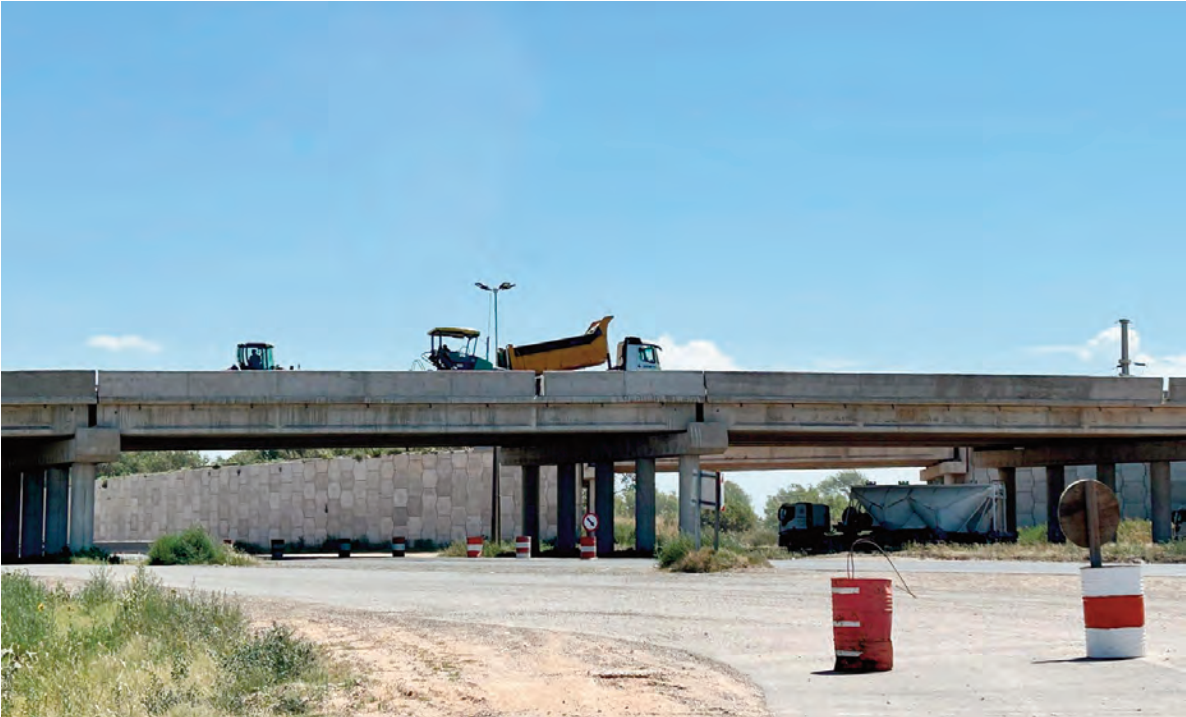
Vialidad trabaja sobre el puente sobreelevado.
