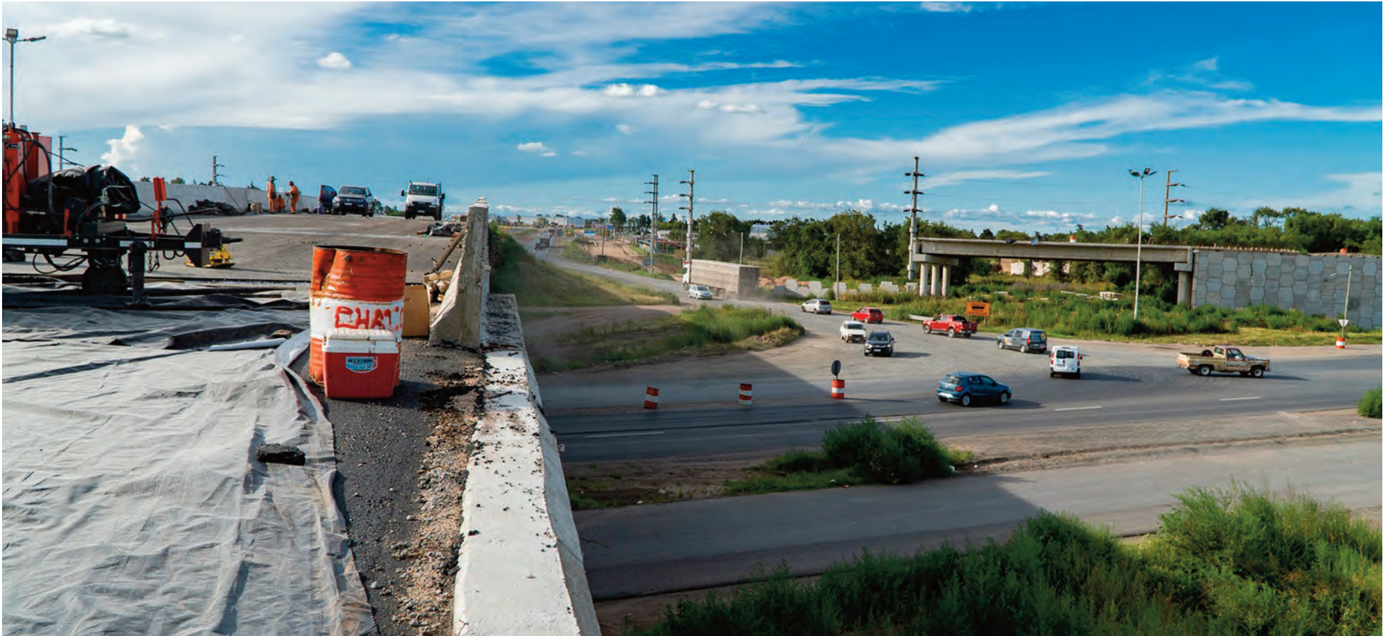
Se avanza sobre la traza del nuevo anillo vial de Río Cuarto.
